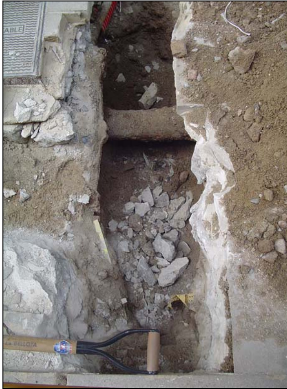
Foto 3: Rebaix efectuat al carrer Unió núm. 9.
