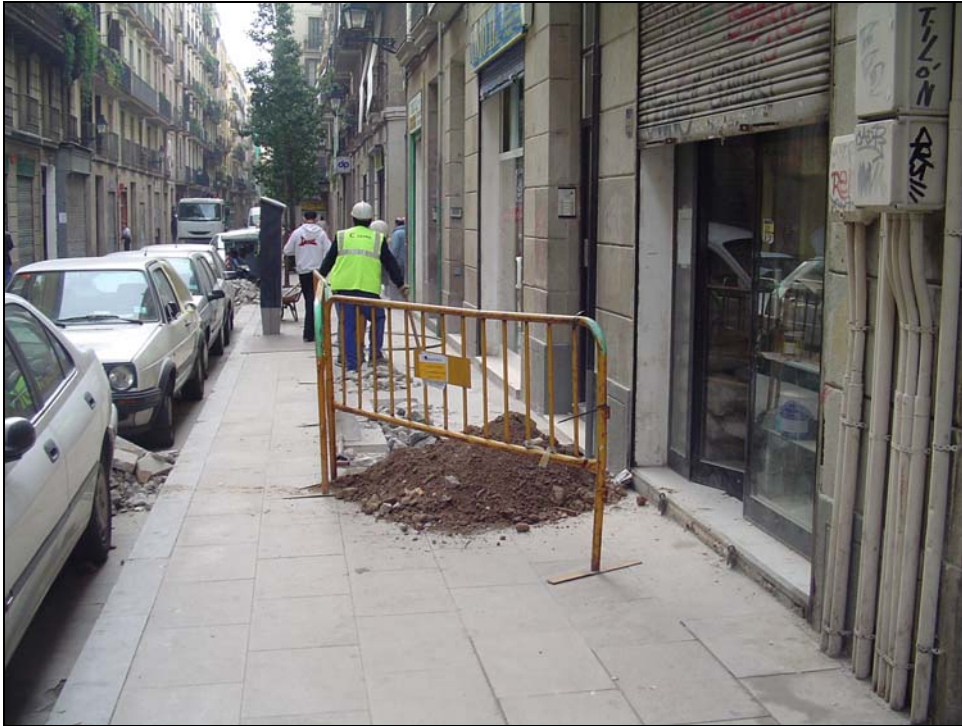
Foto 1: Vista general del carrer Unió durant els treballs constructius.
