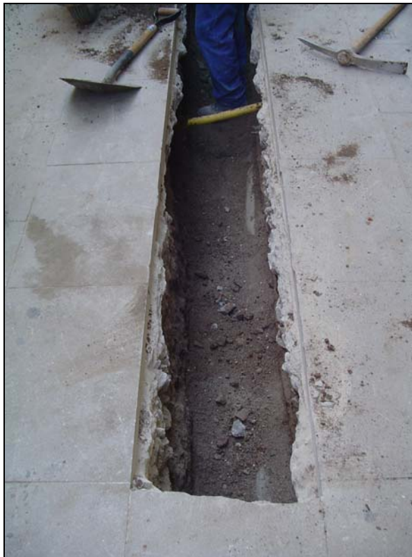
Foto 2: Vista general del la rasa oberta al carrer Unió, tram núm. 20-22.
