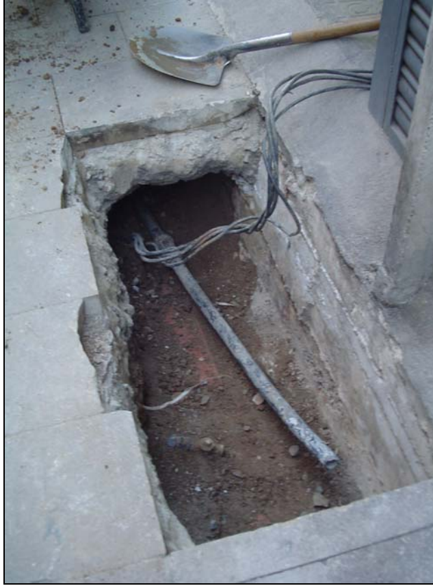
Foto 5: Detall de la rasa al carrer Unió núm. 7.
